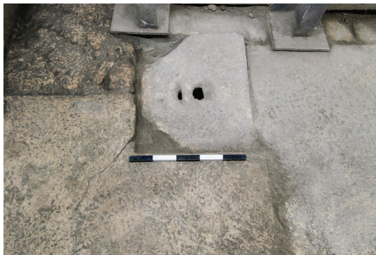
איור 9. מבט על לוח הכיסוי של תא הביקורת היורד ממפלס הרחוב אל תעלת הניקוז.
